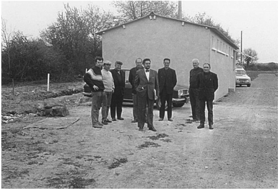
Réunion finale de chantier à l'occasion de la construction de ces vestiaires en 1973
